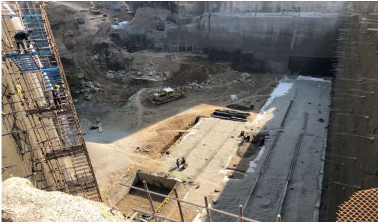
تصاویری از عملیات زهکشی فونداسیون در اسفند ماه
